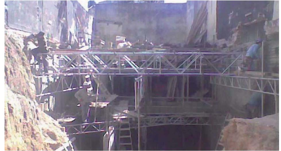
Estructura techos de 2º S.S. y de 1º S.S. ya hormigonados en la zona posterior, avance de hormigonado de fundaciones y apuntalamiento horizontal de troneras y columnas hacia el frente.
