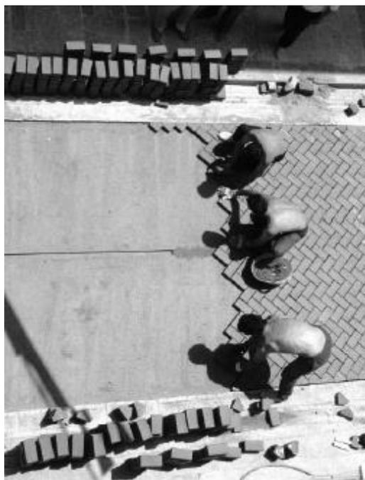
No se colocarán adoquines sobre camas de arena encharcadas o excesivamente húmedas. El posicionamiento y nivelación de cada bloque se efectuar con mazo de goma.
