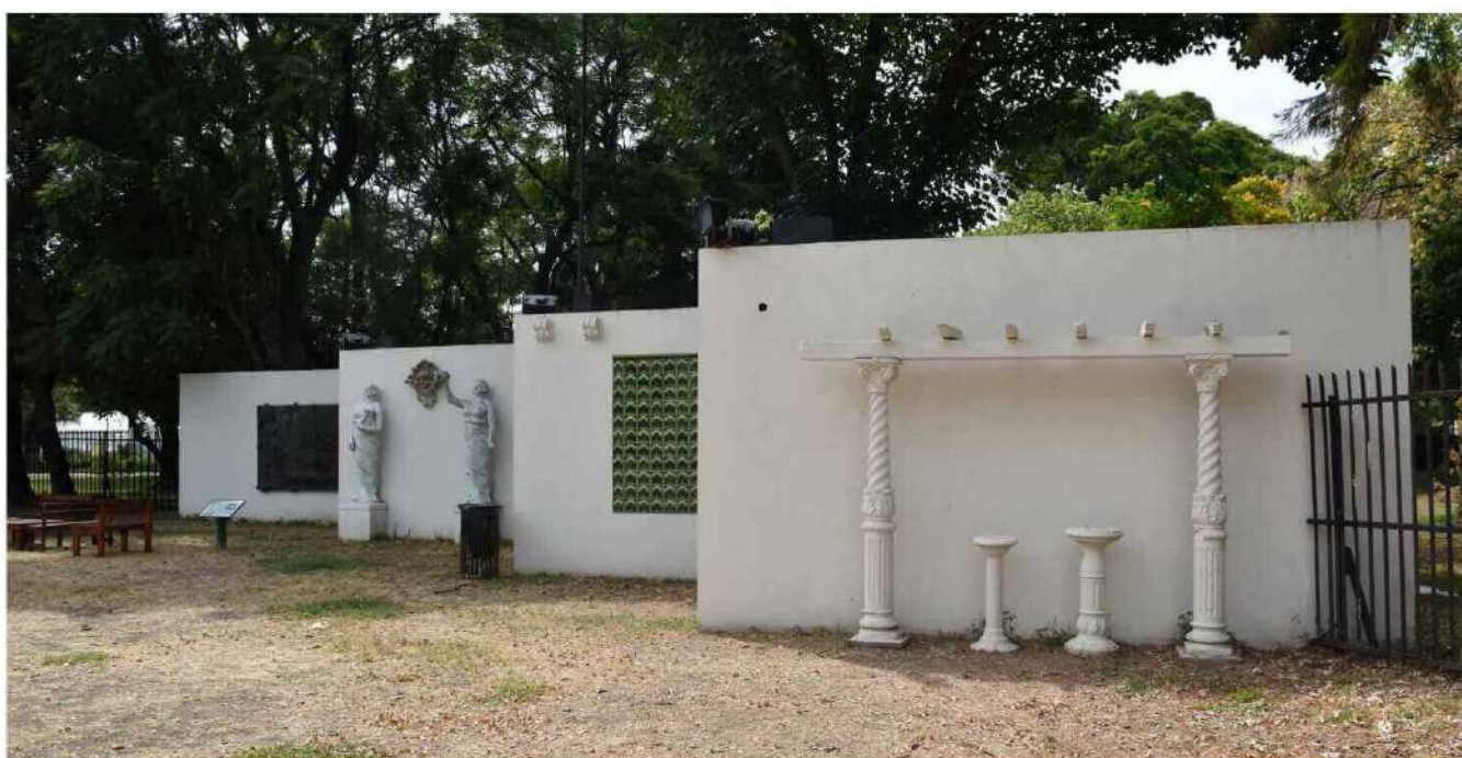
Muros a intervenir.
