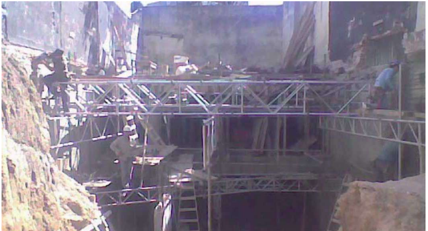
Estructura techos de 2° S.S. y de 1° S.S. ya hormigonados en la zona posterior, avance de hormigonado de fundaciones y apuntalamiento horizontal de troneras y columnas hacia el frente.
